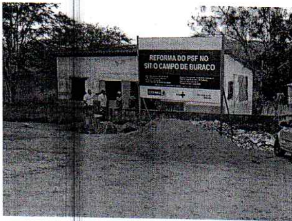
Foto 3 - Visão externa do PSF Campo de Buraco Placa de obra, visão geral da obra
