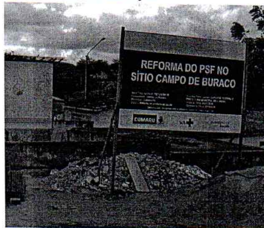
Foto 4 - Visão externa do PSF Campo de Buraco detalhe da placa de obra no local
