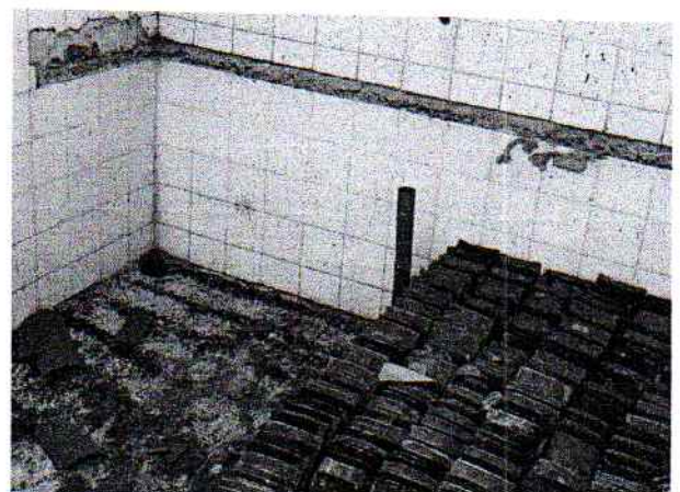
Foto 6 - Visão interna do ambiente a ser reformado
