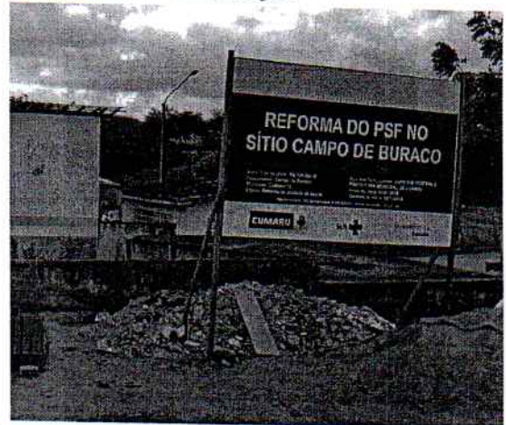
Foto 4 - Visão externa do PSF Campo de Buraco detalhe da placa de obra no local
