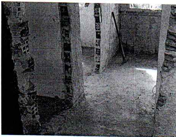
Foto 10 - Visão interna do PSF Campo de Buraco demolição do revestimento de piso
